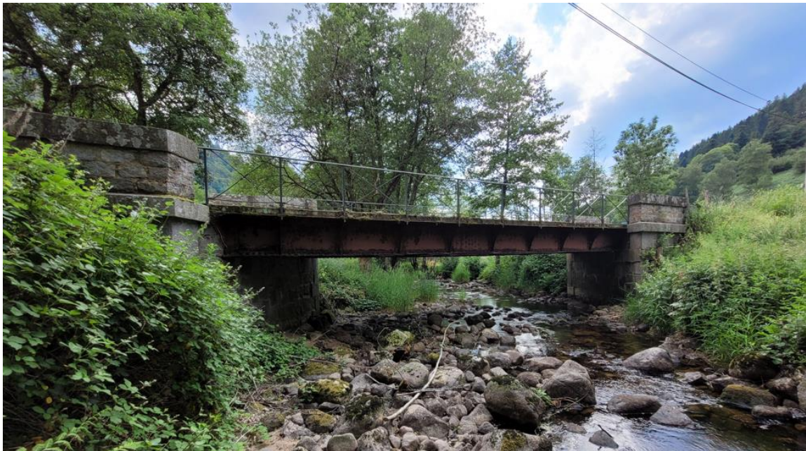
Pont des Truches franchissant le Bouchot à Rochesson – vue de l'amont – juin 2023 – source : l'AdT.
